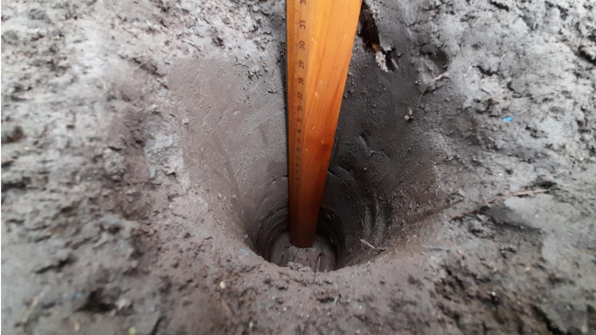
Fotografía 2. Excavación de agujero en el suelo
